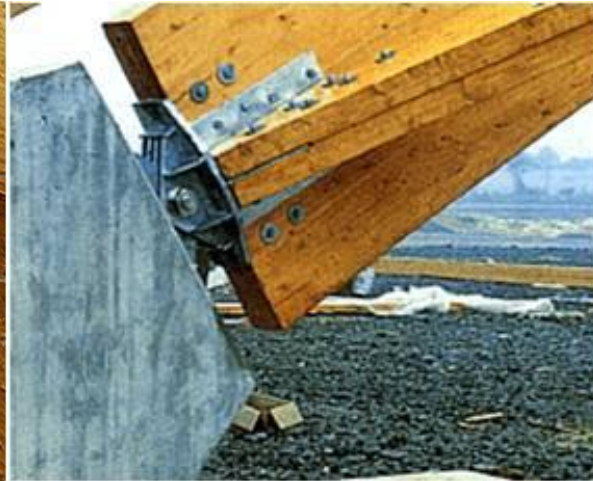
Figura 06 – Ligação de apoio.
