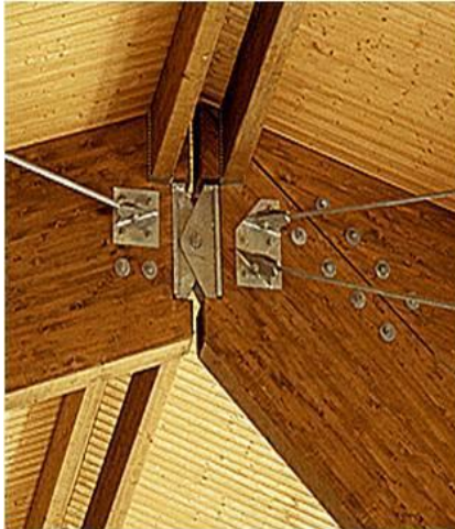
Figura 05 – Ligação entre vigas.
