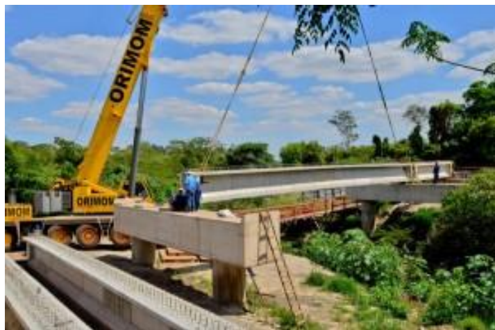
Figura 2 – Montagem de viga longarina com guindaste
