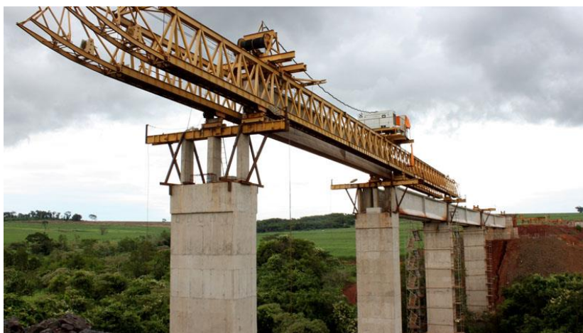
Figura 3 – Montagem de viga com treliças de lançamento
