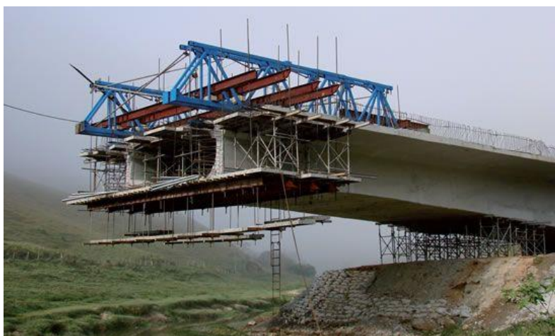
Figura 4 – Pontes por balanços sucessivos
