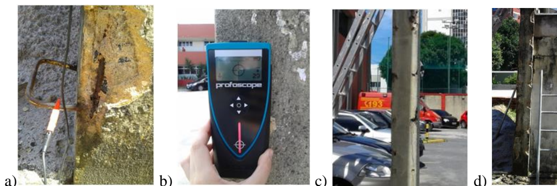
Figura 2: Procedimentos de preparação da estrutura para a inspeção
