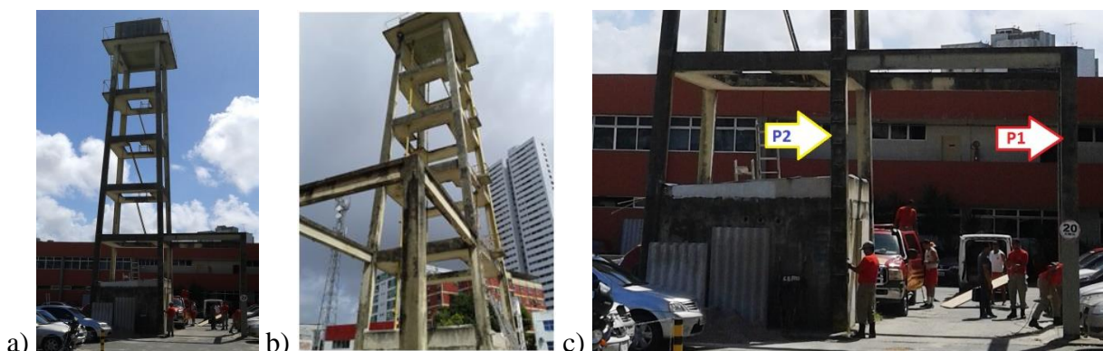
Figura 1: a e b) Vistas da Torre de Salvamento; c) identificação dos pilares inspecionados
