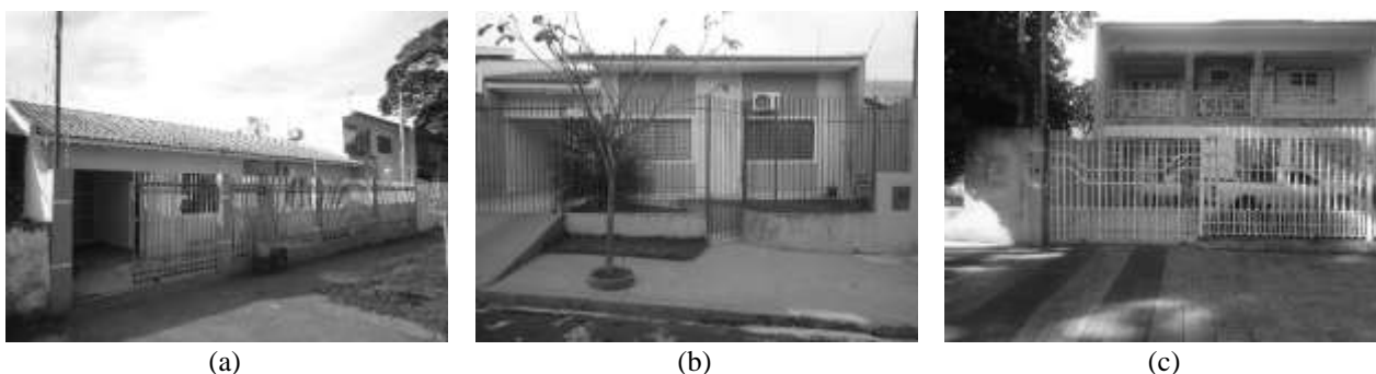
Figura 5 – Aspecto de algumas fachadas das residências estudadas: edificação unifamiliar térrea (a), edificação construída sobre aterro de terra (b) e edificação com 2 pavimentos (c)
