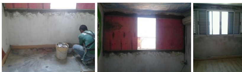
Figura 2 – Proteções na troca de janela
