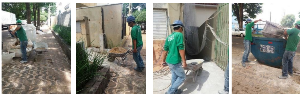
Figura 4 – Transporte de areia através do acesso aberto ao corredor lateral esquerdo
