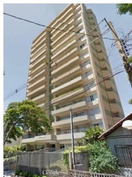
Figura 1 - Edifício Residencial Park anteriormente à reabilitação
