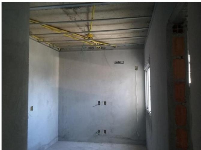
**Figura 2 – Estruturação do forro de gesso**
