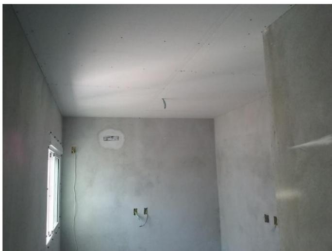
**Figura 3 – Fixação das placas de gesso**
